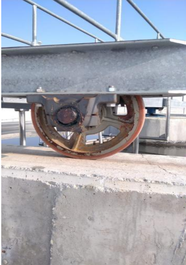
Sıyırıcı köprü tekerlek imalat ve bakımları
