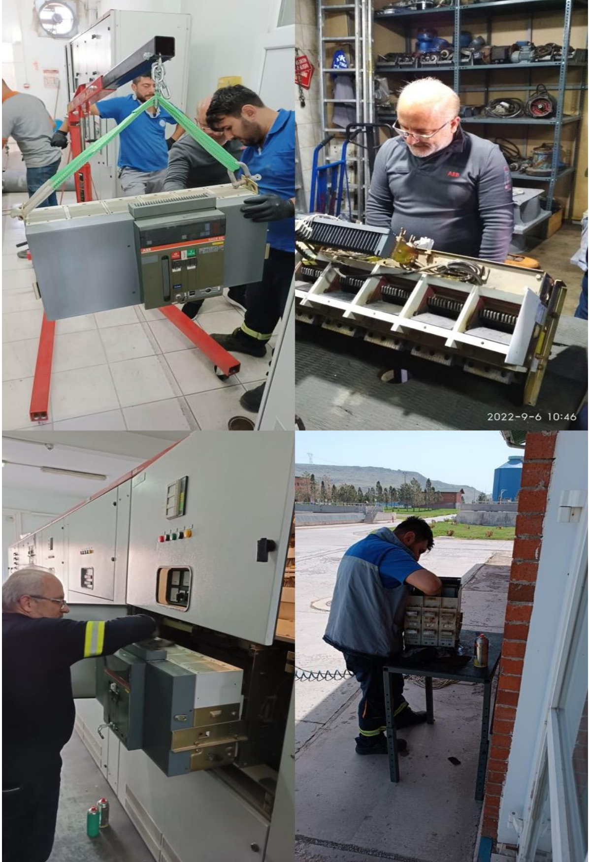
Blower Binası Trafo ve T.Blower Kesici Bakımları
