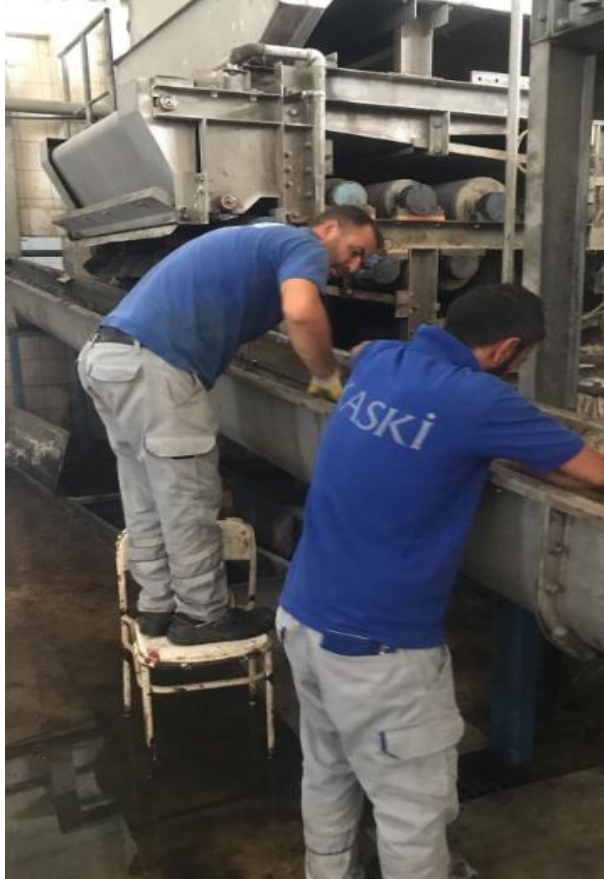
Çamur konveyörlerinde Teflon ve Helezon yenileme çalışmaları
