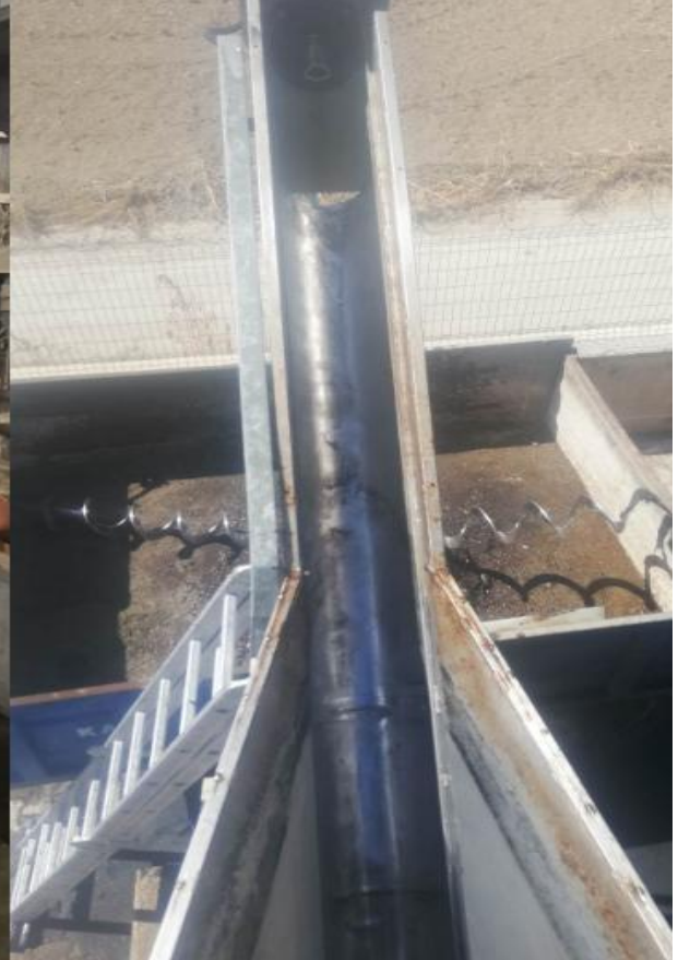
Çamur konveyörlerinde Teflon ve Helezon yenileme çalışmaları
