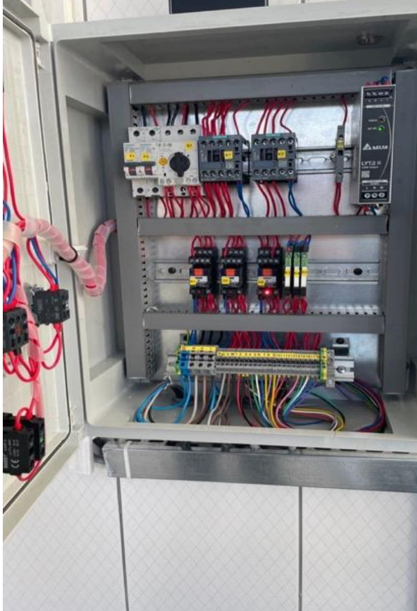
Gürpınar Arıtma Tesisi Jeneratör Transfer Pano değişimi ve Aktuatör Vana-Pano Montajı
