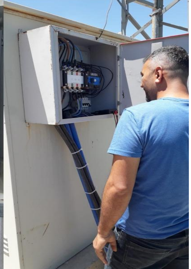
Gürpınar Arıtma Tesisi Jeneratör Transfer Pano değişimi ve Aktuatör Vana-Pano Montajı
